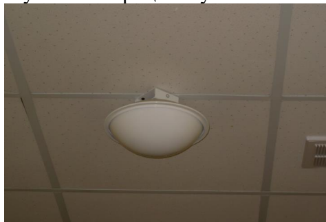
Рисунок 2 – Помещение оборудованное порошковыми пожаротушителями
