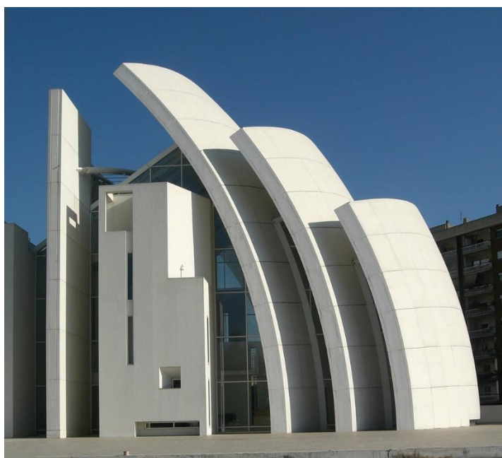
Рисунок 6 – Церковь Dives in Misericordia, построенная из бетона с добавками наночастиц диоксида титана
