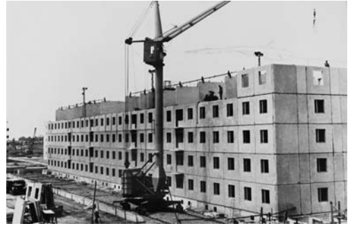
Строительство пятиэтажного жилого дома. Город Волжский
