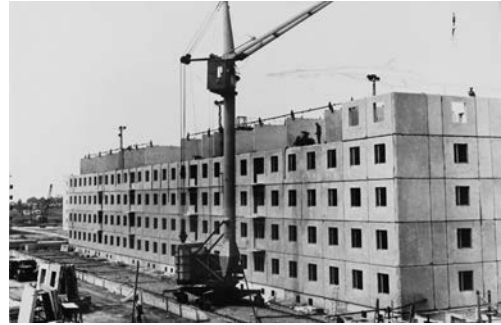
Строительство пятиэтажного жилого дома. Город Волжский
