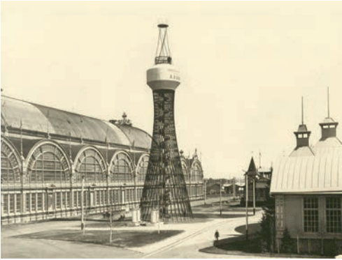
Гиперboloидная башня. Инженер В. Г. Шухов
