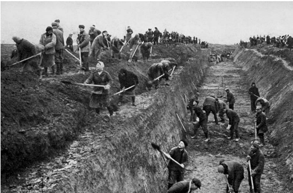
Строительство оборонительных сооружений под Москвой. Осень 1941 г.
