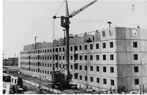
Строительство пятиэтажного жилого дома. Город Волжский
