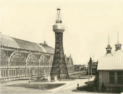
Гиперboloидная башня. Инженер В. Г. Шухов
